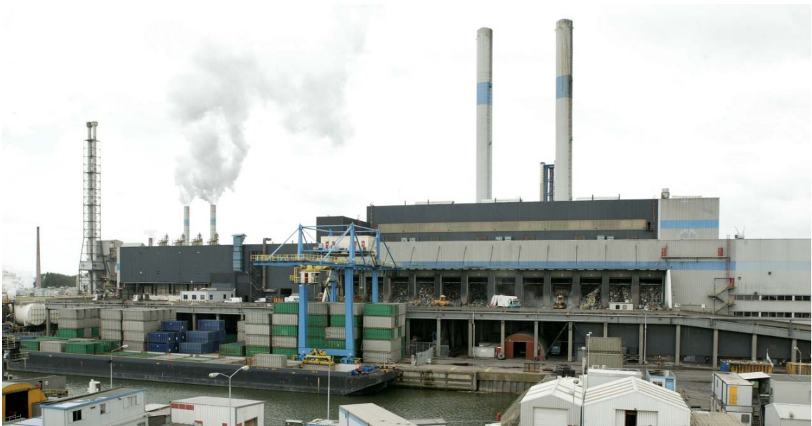
Abb.: Schrottbunker der AVR
